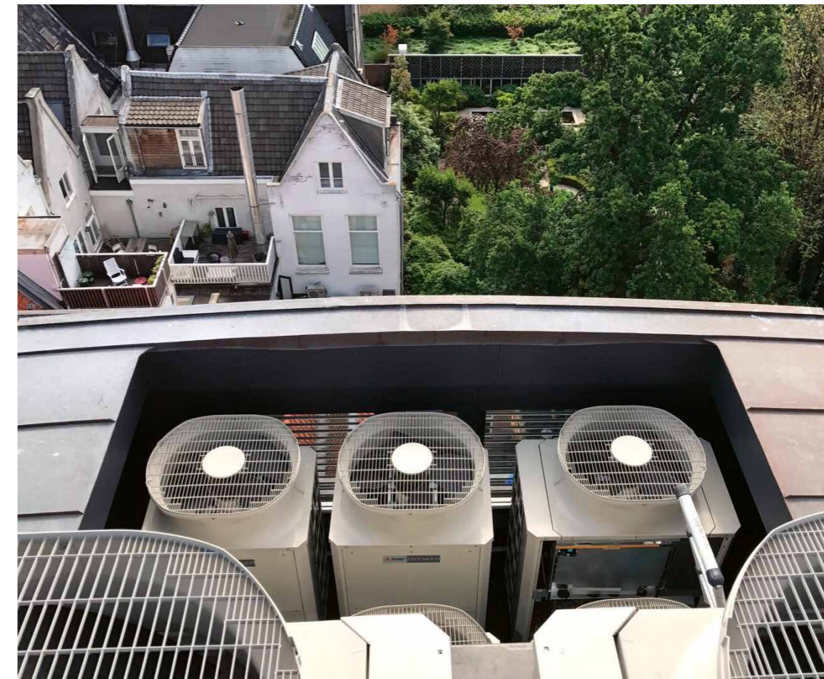
Neuer Dachaufbau mit den Klimageräten, die in einem neu gebauten Außenraum versenkt wurden.
