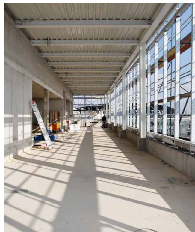
Rohbauzustand und Visualisierung des Interior Designs von Kitzig Interior Design der Rooftop-Bar im Indigo: Clubatmosphäre durch das außergewöhnliche Lichtspiel der farbig getönten Fenster.
