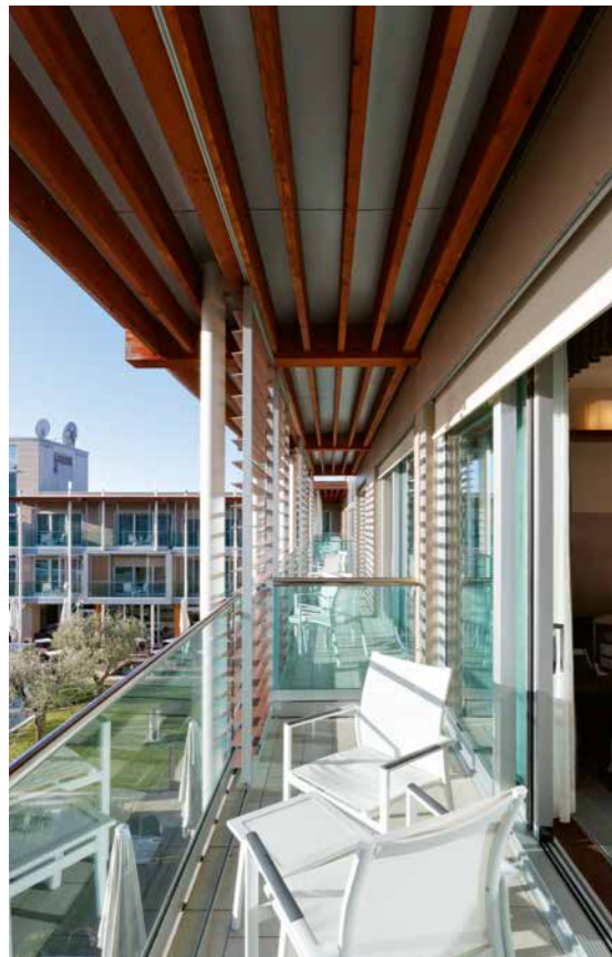
Die Holzbauweise bringt nicht nur energetische Vorteile mit sich, sondern ermöglicht auch einen hohen Grad an Vorfertigung. Der Rohbau wurde in nur drei Monaten hochgezogen.
