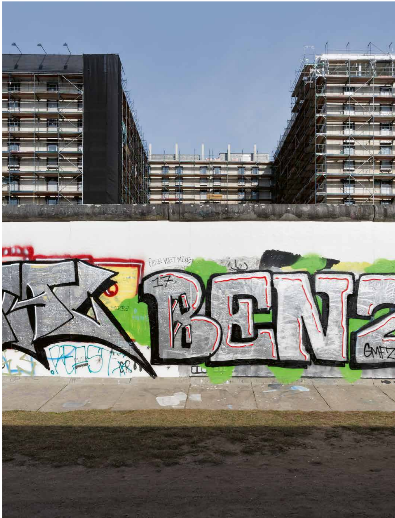
Baustelle an der East Side Gallery: Der Mercedes-Platz soll das Herz des Stadtquartiers werden. Zur Mühlenstraße bilden die flankierenden Baukörper eine kammartige aufgelöste und doch durch die Fassadengestaltung und Materialität einheitliche verbindende Stadtkante. Im U-förmigen Bauteil finden sich die Hotels Hampton by Hilton Berlin City East und Indigo Berlin City – East Side. Im Herbst 2018 ist die Eröffnung aller Gebäude geplant.
