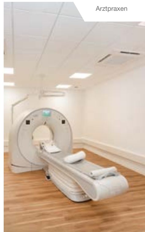
Insgesamt 50 Innengeräte: 4-Wege-Deckenkassetten, Wandgeräte, Kanaleinbaugeräte
