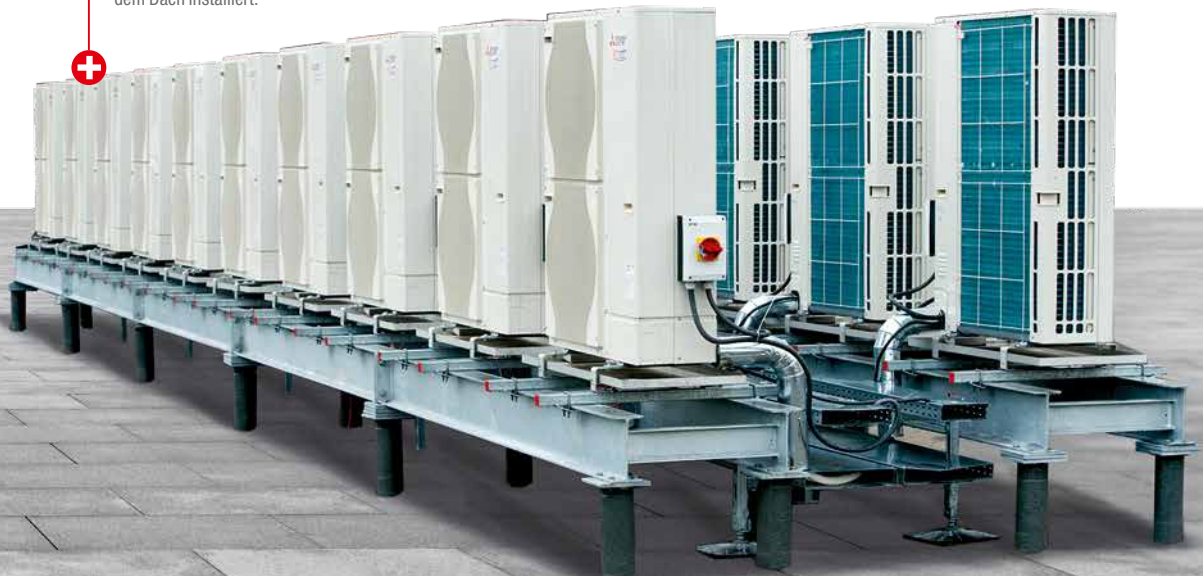
Die Außeneinheiten wurden auf dem Dach installiert.
