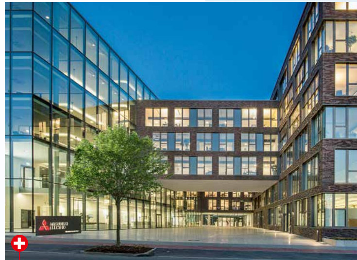
Die Mitsubishi Electric Deutschlandzentrale nutzt Zentrales Gebäudemanagement-System MAPS SCADA.
